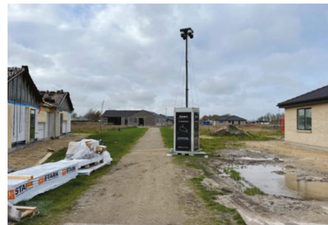
Med 360 graders TV-overvågning kan Elwerks tårne anvendes til at beskytte ubemandede steder, midlertidige installationer og til at forstærke bemandet overvågning på stedet. Foto: Elwerk
